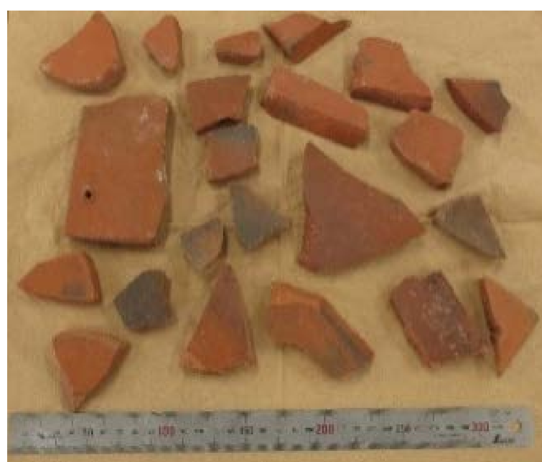
破片状の破損瓦
